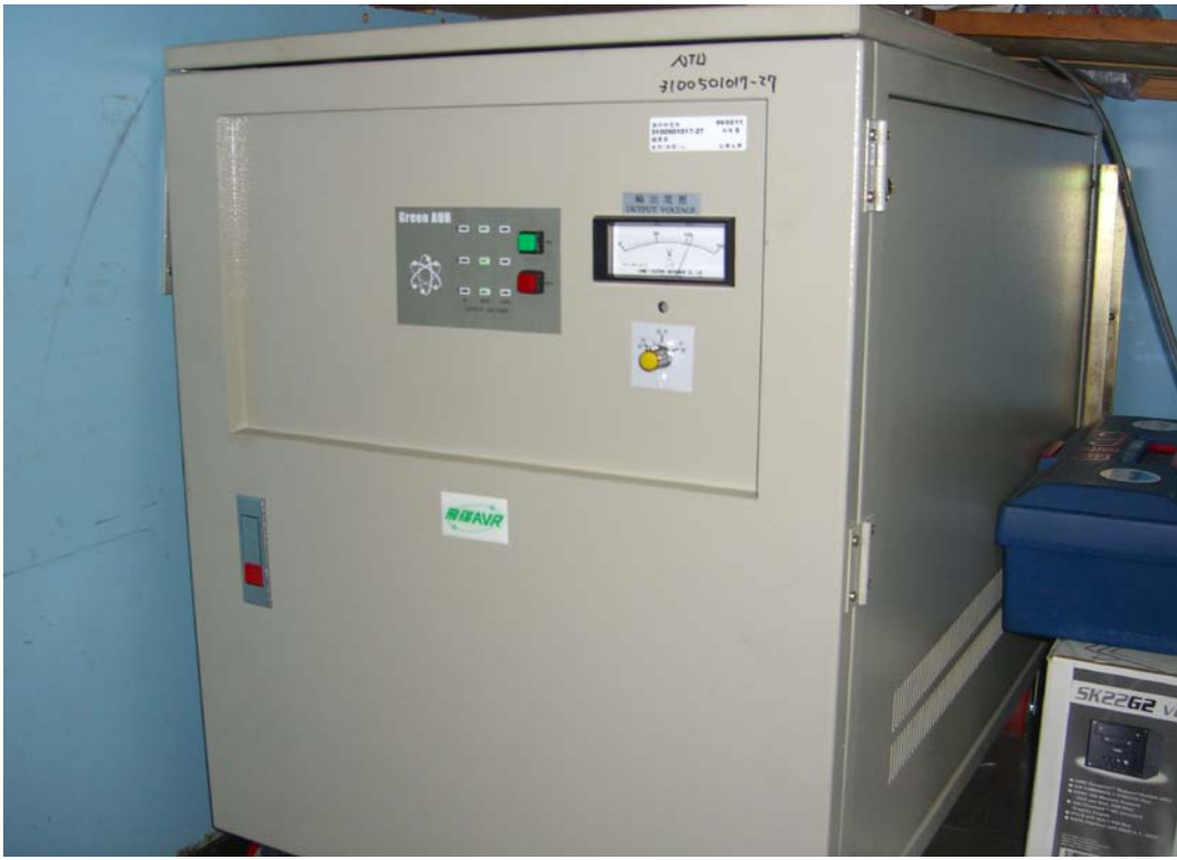
圖 5 「海研一號」研究船不斷電系統
