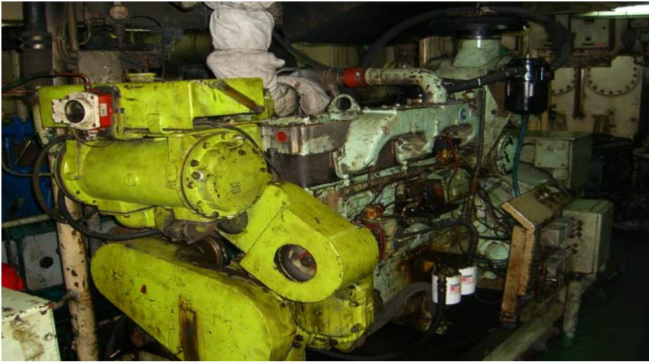
圖 2 「海研一號」研究船舊發電機
